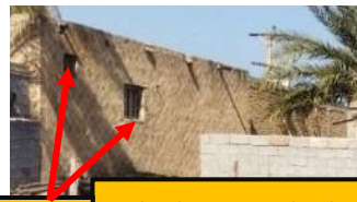
پنجره های کوچک آجرنمای ساختمان سنتی در خانه های معاصر (به صورت مربع و دورچین کله)
