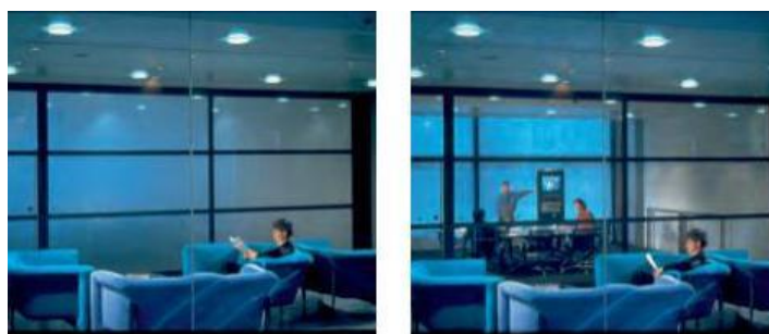
تصویر ۱۰ - شیشه‌های الکتروکرومیک (Ritter, 2007)
