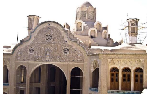
تصویر شماره ۱۰- بادگیرها و نورگیرهای سقفی و انعکاس در آب ( http://archline.ir )
