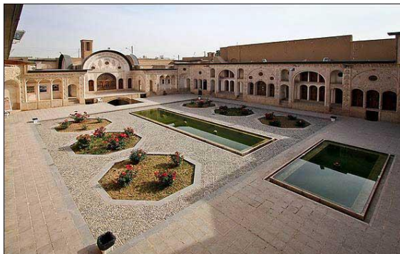
تصویر شماره ۱۷- تزیینات و کنترل نور فضاها و شکل‌گیری فضاها در اطراف حیاط انعطاف‌پذیری و قابلیت استفاده فضا در چندقرن ( mehrnnews.com )
