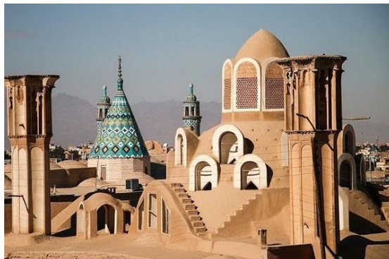
تصویر شماره ۴- تھویه و نورپردازی بصورت همزمان از پنجره‌های سقفی و هوای گرم بالای سقف راحت‌تر خارج و تنوع مصالح زیبایی همخوان ( http://archline.ir )
