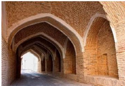
تصویر شماره ۳- قرارگیری ساباط‌ها بر روی پایه‌های قطور- مأخذ: (آیوزیان، ۱۳۸۷).
