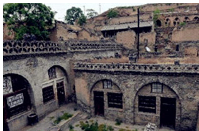
تصویر ۸- خانه گودال باغچه ای در منطقه شیجاگو، چین. اتاقها در بستر زمین و در چهار طرف گودال باغچه حفر شده اند و با آجر نماسازی گشته اند. (مأخذ: Knapp, Ronald G, 1989)
