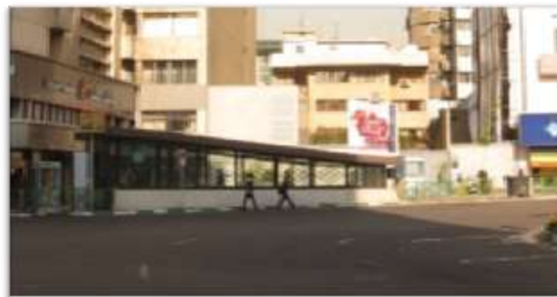
تصویر شماره ۸ : ایستگاه مترو (منبع: نگارنده)
