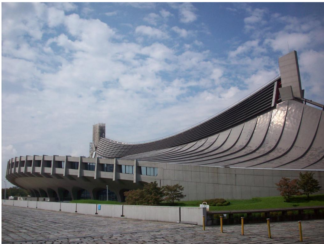
تصویر شماره ۵: کنزو تانگه، ساختمان ورزشی ملی المپیک توکیو، ۱۹۶۴ (منبع: archdaily.com) Kenzo Tange, Tokyo Olympic National Gym, 1964
