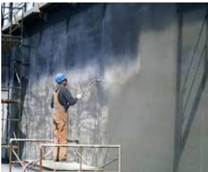
شکل ۲- پوشش نفوذگر کریستال شونده Aquafin IC (منبع: www.clinicheton.com)
