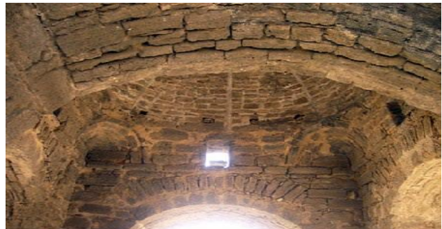
شکل ۹- شیوه پوشش چهارطاقی نیاسر با کمک تویزه گچی (مأخذ: رضایی‌نیا، ۱۳۹۷: ۱۴۵)
