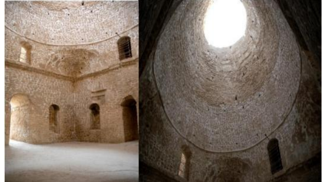
شکل ۵- گنبد کاخ؛ دیداز نمای داخلی، کاخ فرورآباد و استفاده از فیلیوش برای انتقال از سطح مربع به دایره (مأخذ: کیانی و فیروزمندی شیره جینی، ۱۳۹۸: ۱۵۴)
