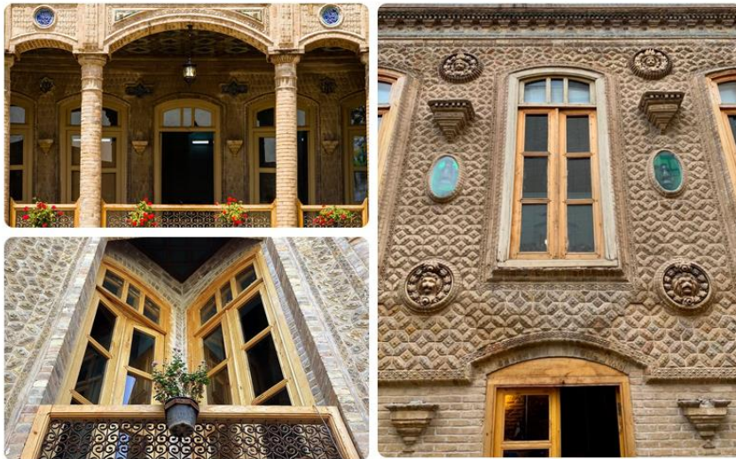
شکل ۳- تزیینات در نمای خانه داروغه (نوحی بزنجانی و عطائی کاریزی، ۱۳۹۸)
