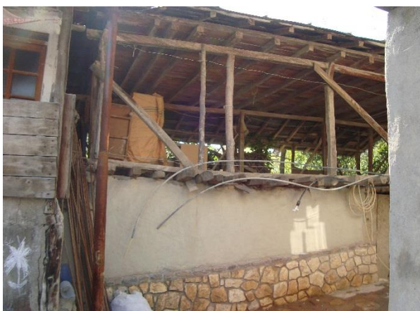
تصویر شماره (۷): جزئیات استفاده از سنگ در نمونه های مسکن بومی روستایی مورد مطالعه
