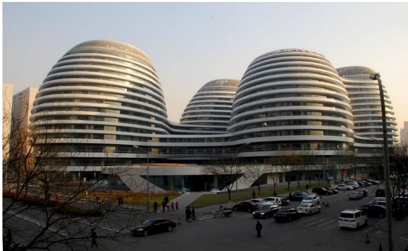
شکل ۶- ساختمان گلکسی سوهو، پکن، چین. معماران زها حدید، ۲۰۱۲ (ماخذ: Qobadian; 2003)
