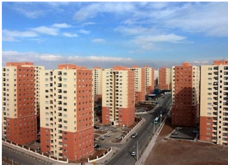
شکل ۲- مجتمع مسکن مهر کیهانشهر (ماخذ: سایت تسنیم، ۱۳۹۸)
